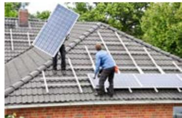
La manipulation d'un module est interdite si un câble de liaison ne répond pas aux conditions précédentes et si la tension  $U_{0c}$  STC de ce module est supérieure à 60 V en courant continu.
